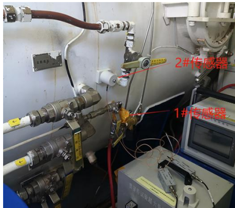
管道内泄漏定量检测
